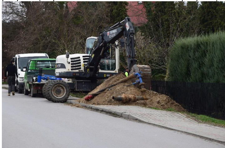
Modernizacja sieci wodociągowej w Dzierdżówce
