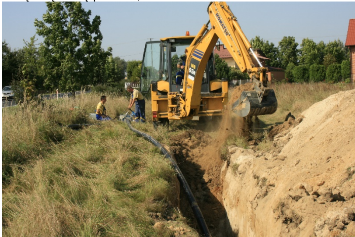
Budowa sieci kanalizacyjnej
