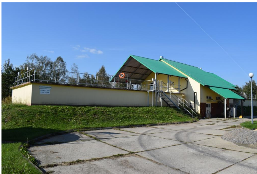
Fot. 40. Oczyszczalnia ścieków w Kępie Zaleszańskim
