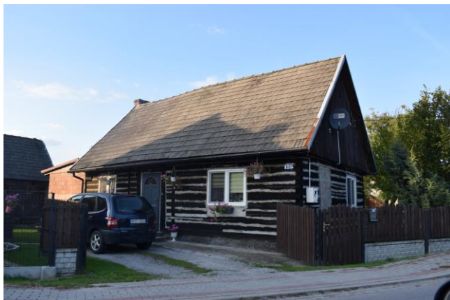
Fot. 7. Drewniany budynek mieszkalny w Zbydniowie
