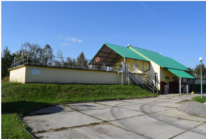
Fot. 40. Oczyszczalnia ścieków w Kępie Zaleszańskim
