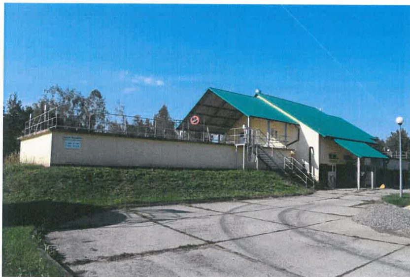
Fot. 40. Oczyszczalnia ścieków w Kępie Zaleszańskim
