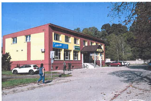
Fot. 5. Zabudowa usług handlu w centrum Zaleszan
