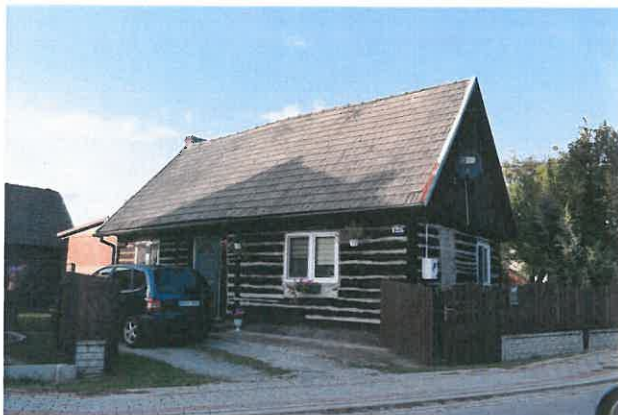
Fot. 7. Drewniany budynek mieszkalny w Zbydniowie
